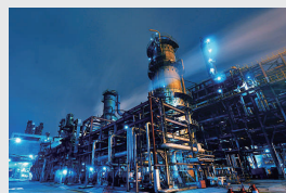
プラント設備
